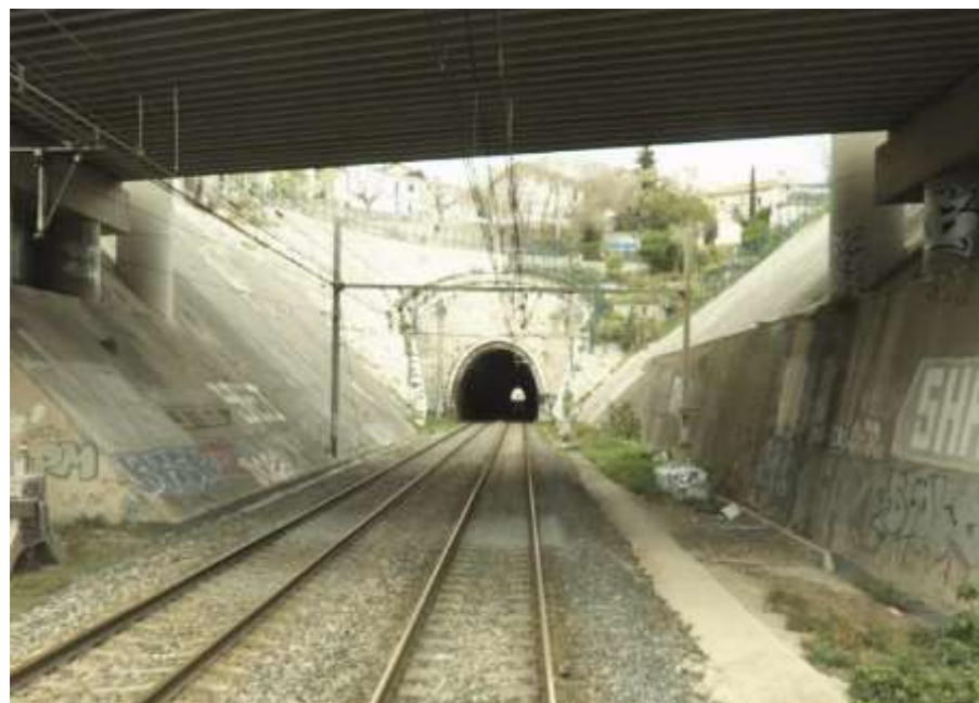
Figure 76 : Perrés tête sud du tunnel de Saint-Louis (EGIS, 2021)
