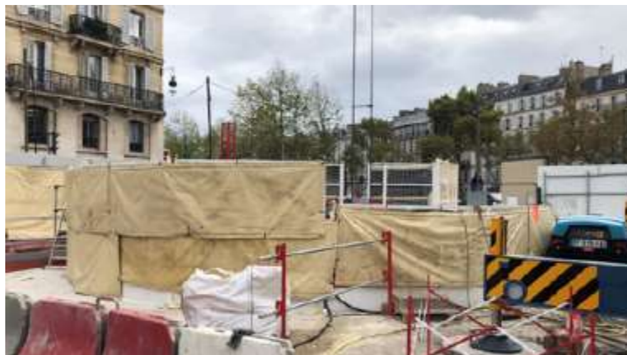
Figure 205 : Exemple de bâches installées autour d'un atelier bruyant de courte durée
