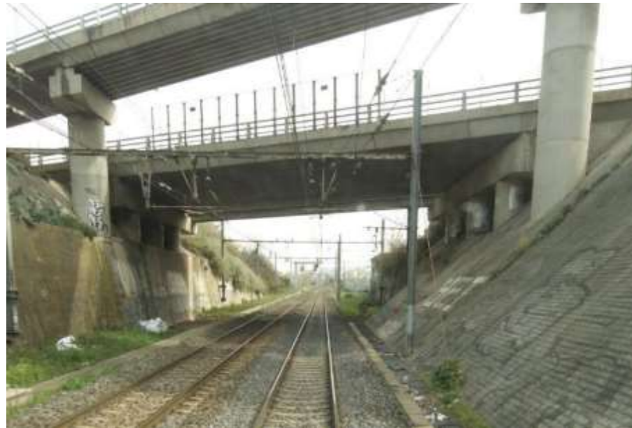
Figure 75 : Vue d'ensemble sous l'ouvrage (EGIS, 2021)
