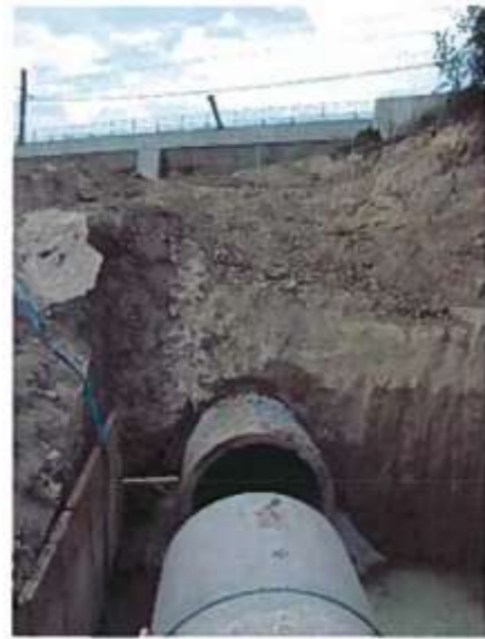
Figure 85 : Buse sous voie ferrée au nord (Etude hydraulique loi sur l'eau, 2006)
