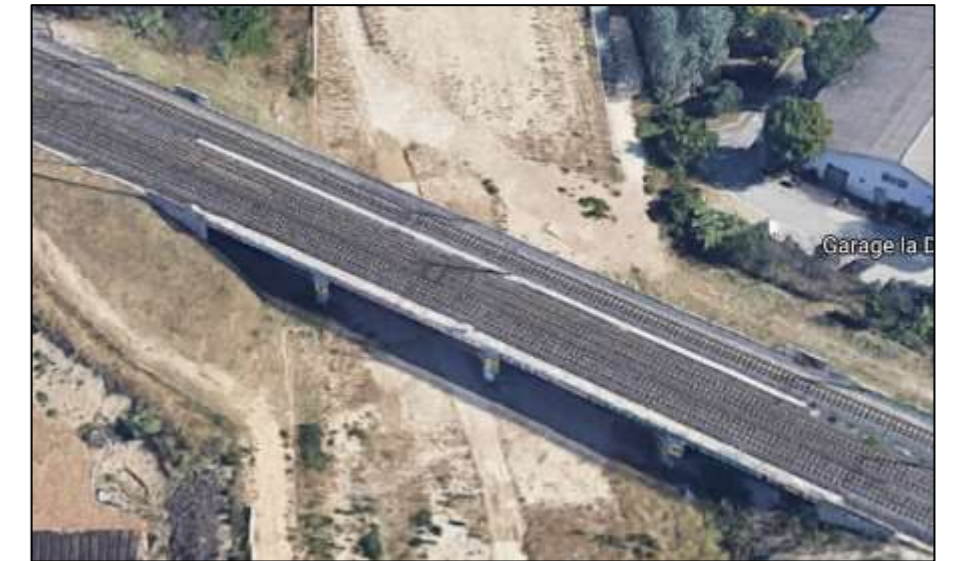
Figure 81 : Pont rail de la L2 (Google Maps, 2021)
