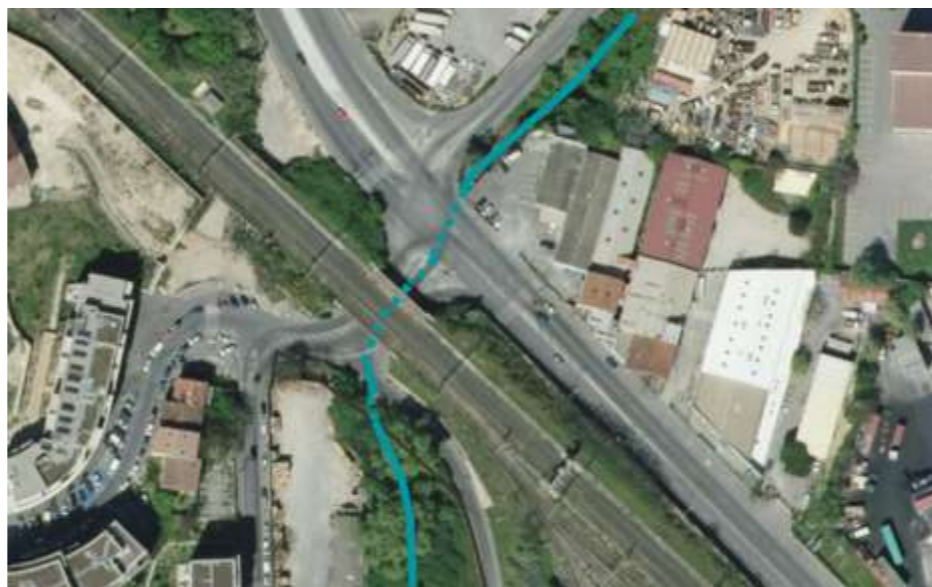
Figure 66 : Situation actuelle des ponts-rail Commanderie et Chatelier
