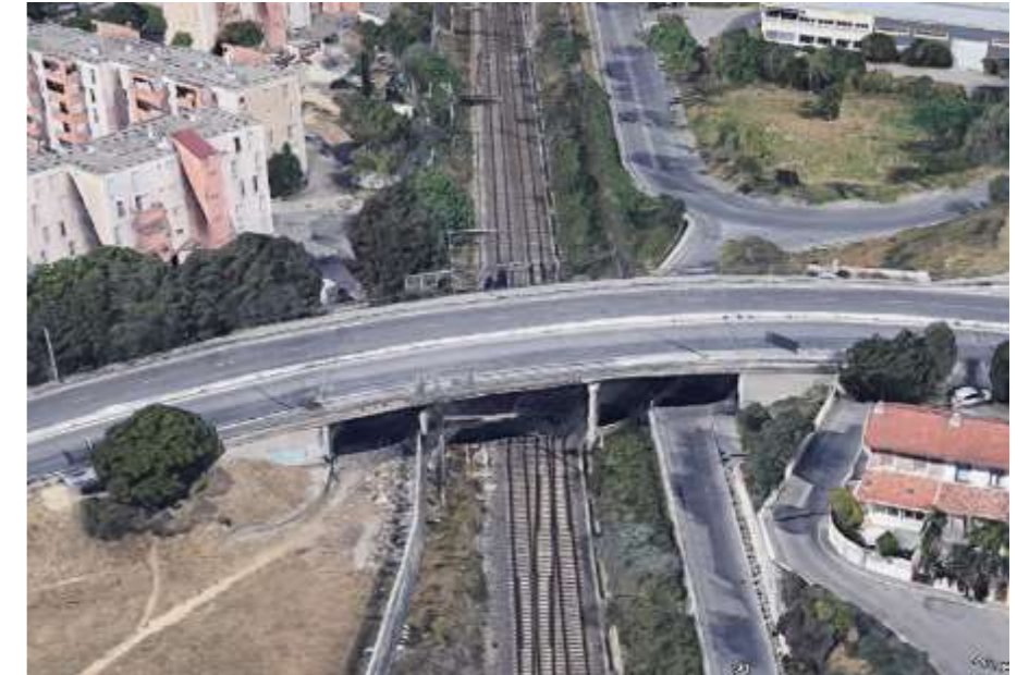
Figure 71 : Pont route de l'avenue du Marché National (Google Earth, 2021)
