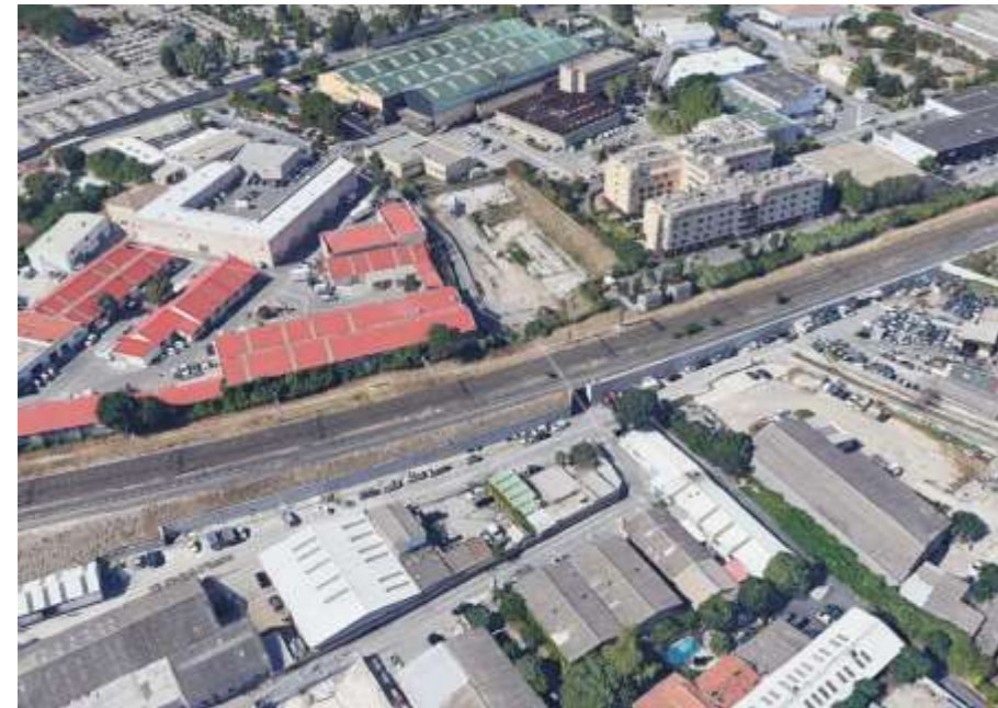
Figure 78 : Accès nord du pont rail ZI Saint-Pierre (Google Earth, 2021)
