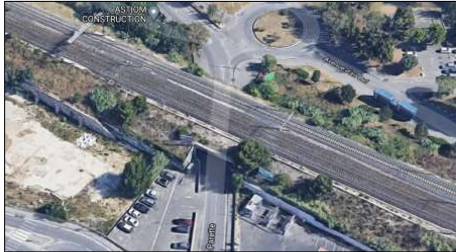
Figure 82 : Pont rail chemin de la Parette ( Google Maps, 2021)
