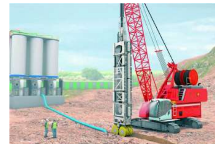
Figure 89 : Exemple d'hydrofraise (Le Moniteur, 2020)
