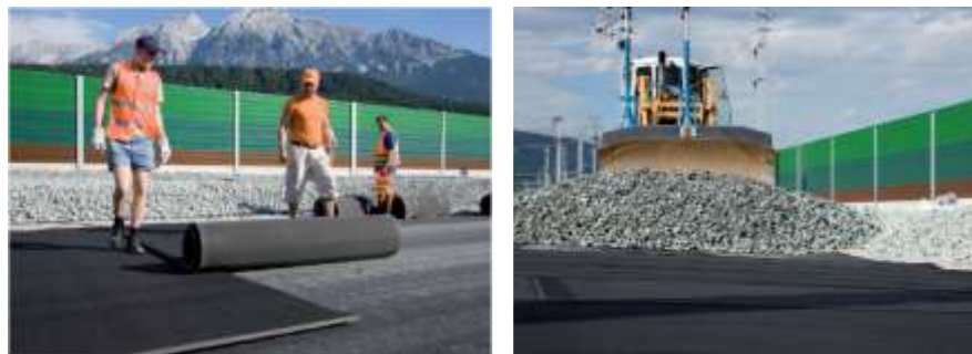
Figure 234 : Illustrations de la mise en place de tapis sous ballast
