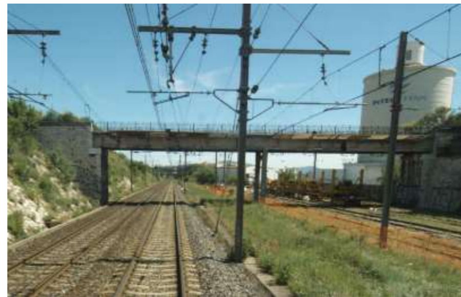
Figure 70 : Passerelle des Maures (EGIS, 2021)
