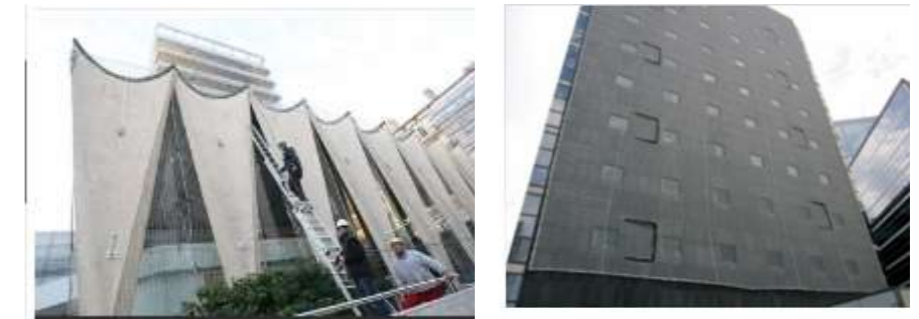
Figure 208 : Exemple de mise en œuvre de filets de protection
