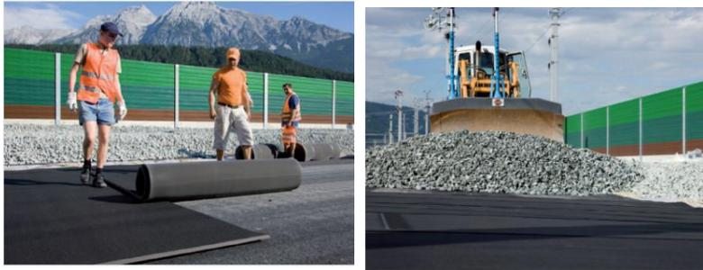
Figure 71 : Illustrations de la mise en place de tapis sous ballast
