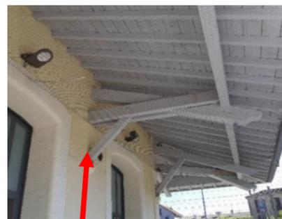
photo prise sur site : Filet anti-pigeons sous l'auvent de la gare des Arcs (Ecosphère)
