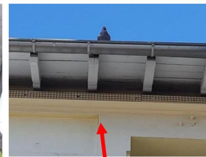
photo prise sur site : Grillage interdisant l'accès de l'avifaune aux corniches (Ecosphère)
