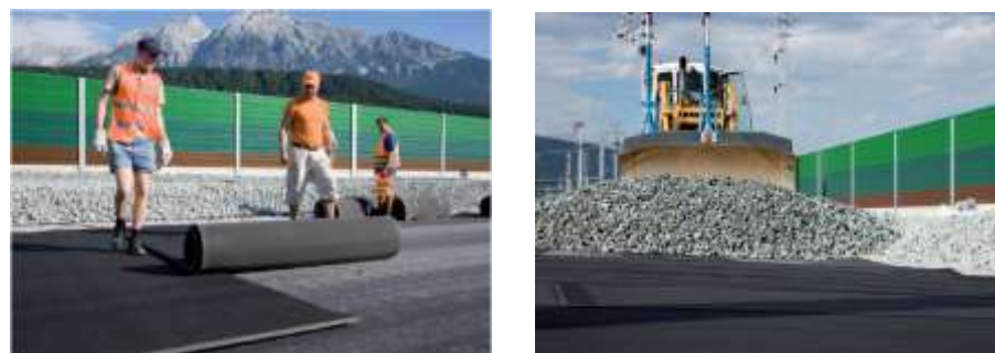
Figure 99 : Illustrations de la mise en place de tapis sous ballast
