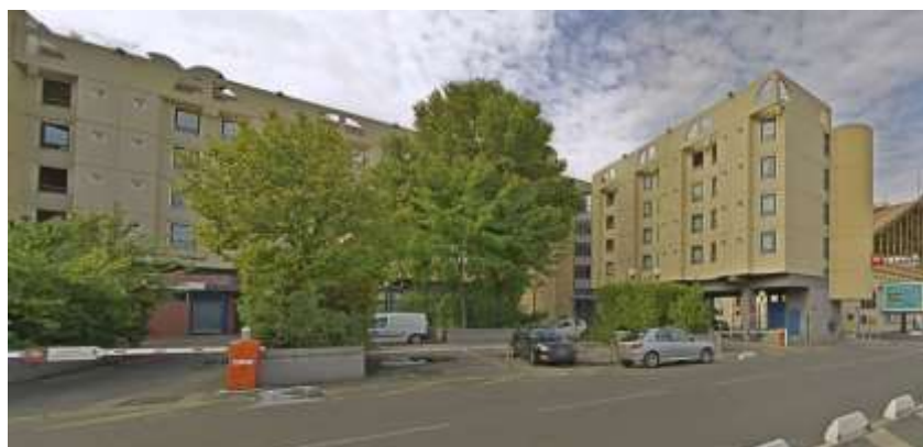
Figure 78 : l'hôtel Ibis en gare Saint Charles (source : google maps)
