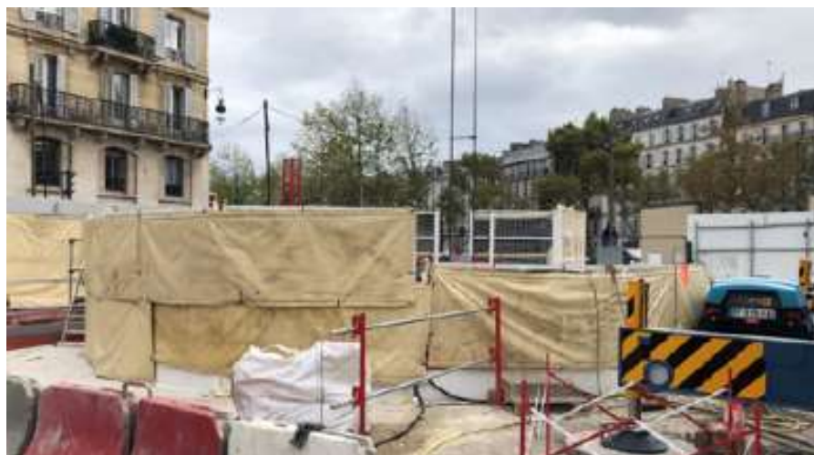
Figure 84 : Exemple de bâches installées autour d'un atelier bruyant de courte durée
