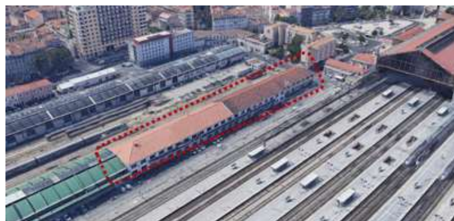
Figure 24 : la partie de la halle A (toiture tuiles) conservée durant la phase 1
