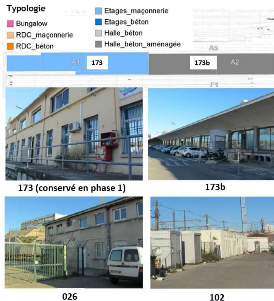
Figure 80 : typologie et photos des différents bâtiments à démolir en phase 1 (source : études de recalage - notice technique – démolition des bâtiments - 2019)
