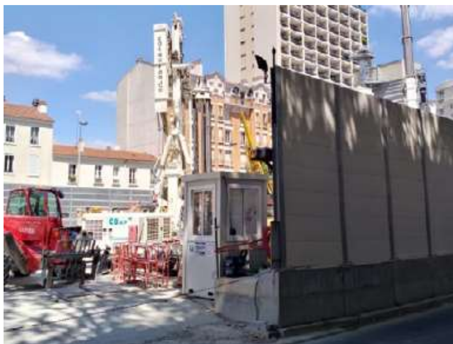
Figure 85 : Exemple d'écran absorbant provisoire mis en œuvre en limite d'emprise du chantier (Source : Acoustb)
