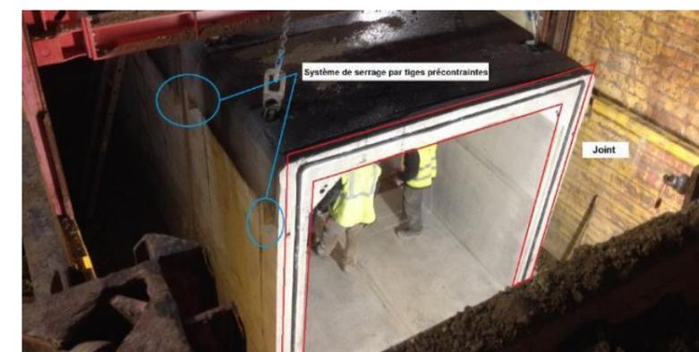
Figure 80 – Exemple de pose d'élément de cadre en gare de Moirans (Systra, 2021)
