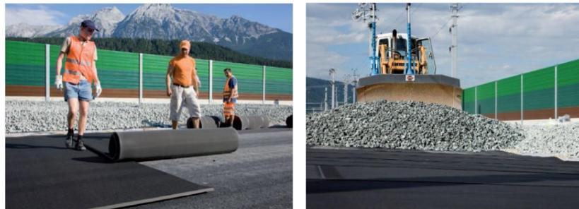
Figure 103 : Illustrations de la mise en place de tapis sous ballast
