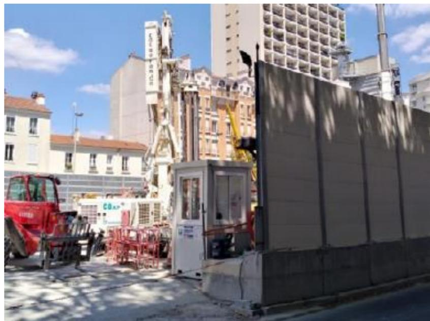
Figure 63 : Exemple d'écran absorbant provisoire mis en œuvre en limite d'emprise du chantier (Source : Acoustb)
