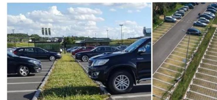
Figure 46 : Exemple de noues drainantes (source : notice hydraulique – AREP – 2021)
