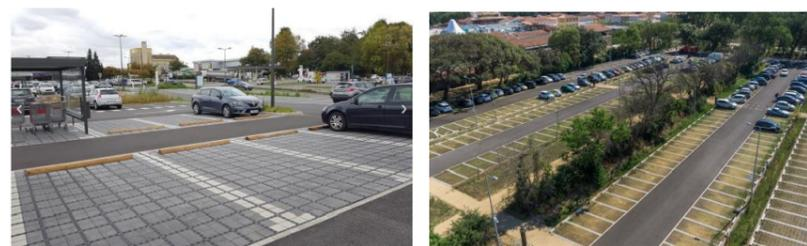
Figure 44 : Exemples de revêtement perméable – EcoVegetal (source : notice hydraulique – AREP – 2021)
