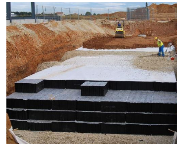
Figure 18 : Exemple de bassin enterré en cours de réalisation, ici de type SAUL (source : Nidaplast)
