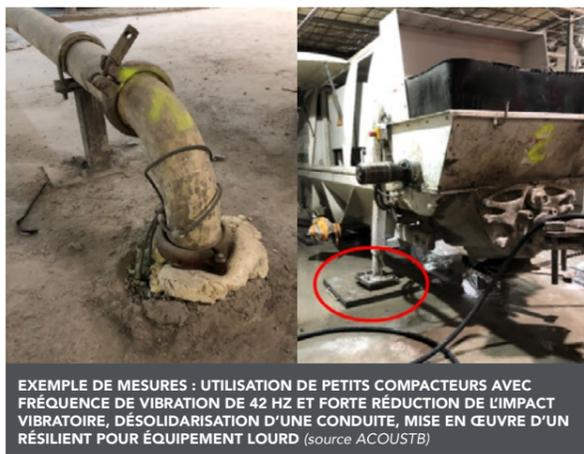
EXEMPLE DE MESURES : UTILISATION DE PETITS COMPACTEURS AVEC FRÉQUENCE DE VIBRATION DE 42 HZ ET FORTE RÉDUCTION DE L'IMPACT VIBRATOIRE, DÉSOLIDARISATION D'UNE CONDUITE, MISE EN ŒUVRE D'UN RÉSILIENT POUR ÉQUIPEMENT LOURD (source ACOUSTB)
