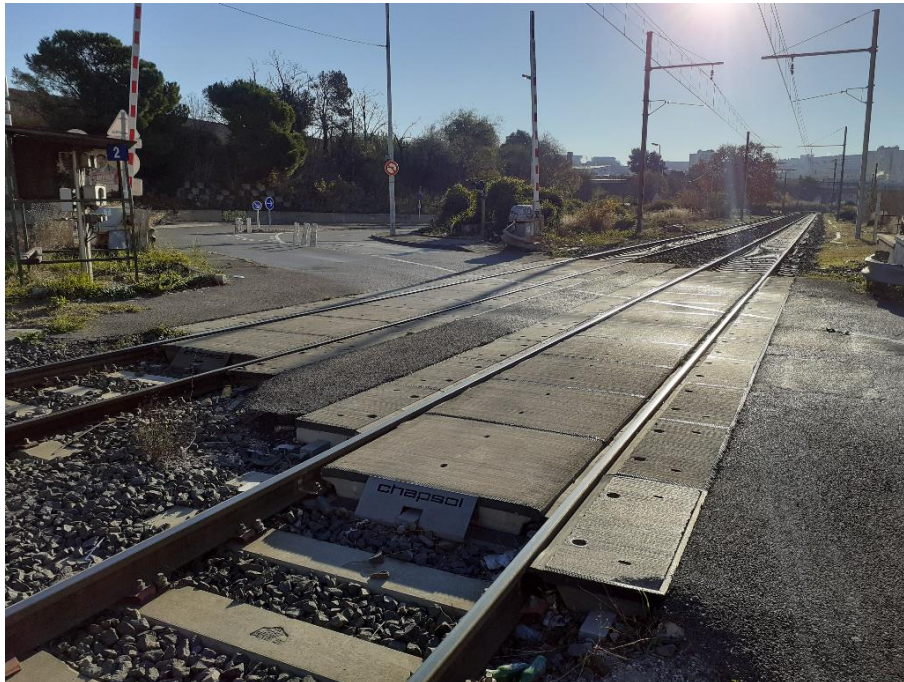
Photo 4 : Platelages Chapsol sur le PN2 (Décembre 2020).
