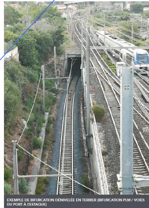
EXEMPLE DE BIFURCATION DÉNIVELLÉE EN TERRIER (BIFURCATION PLM / VOIES DU PORT A DESTAGUE)
