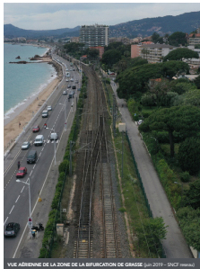
VUE AÉRIENNE DE LA ZONE DE LA BIFURCATION DE GRASSE (juin 2019 - DCT 2019)
