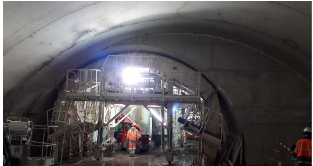
Phase de coffrage du revêtement
