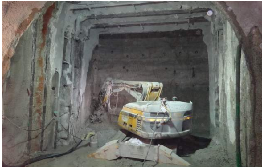
Phase de creusement à la fraise
