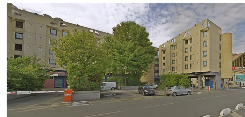
Figure 146 : l'hôtel Ibis en gare Saint Charles (source : google maps)
