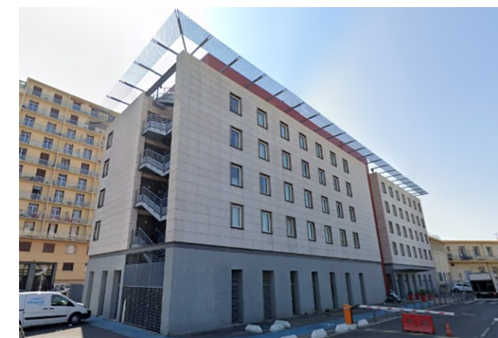
Figure 147 : la résidence Orféa (source : google maps)
