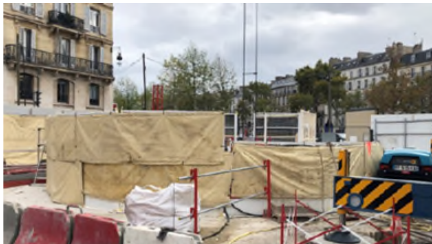
Figure 155 : Exemple de bâches installées autour d'un atelier bruyant de courte durée
