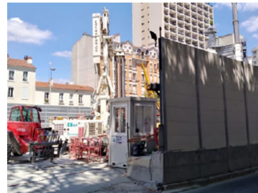
Figure 156 : Exemple d'écran absorbant provisoire mis en œuvre en limite d'emprise du chantier (Source : Acoustb)
