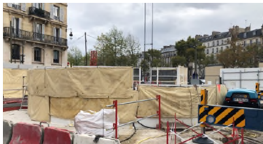
Figure 79 : Exemple de bâches installées autour d'un atelier bruyant de courte durée
