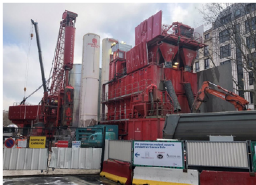
Figure 154 : Exemple de bâches installées en périphérie d'un engin bruyant situé en hauteur (Source : Acoustb)
