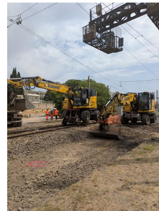
Figure 22 : Travaux d'aménagements de voie au sein du technicentre de Blancarde (mai 2025)
