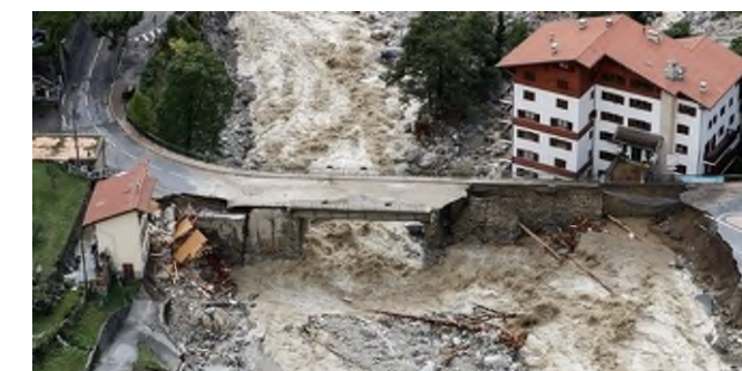
Figure 76 : Crue de la Vésubie, 2020 (catastrophes-naturelles.fr)
