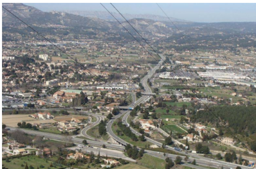
Figure 110 : Vue aérienne A501/A50 - Sud d'Aubagne (SDAP LNPCA)
