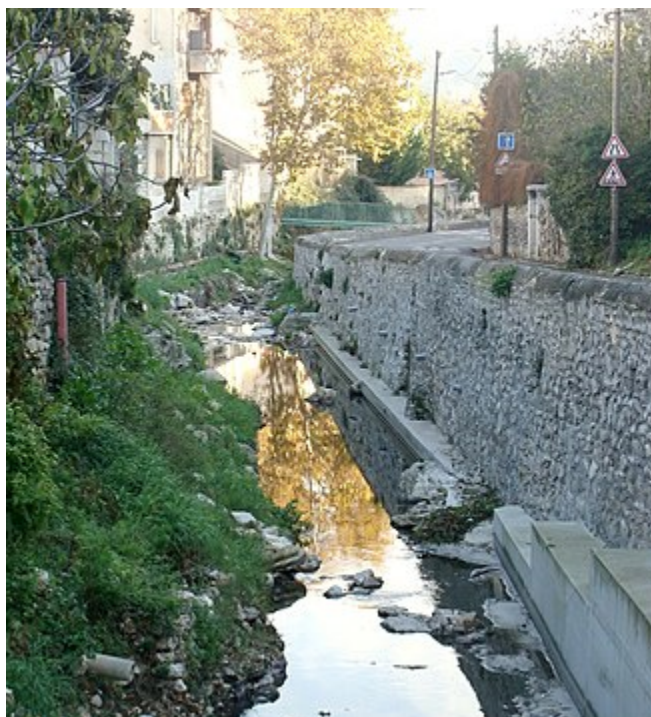
Figure 79 : Ruisseau des Aygaldes à Marseille (Wikipédia)
