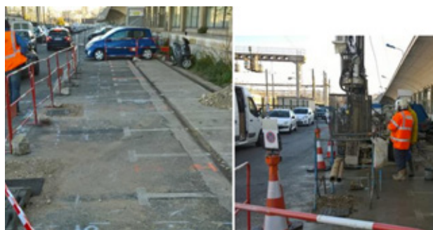
Exemple d'interventions pour les sondages géotechniques
