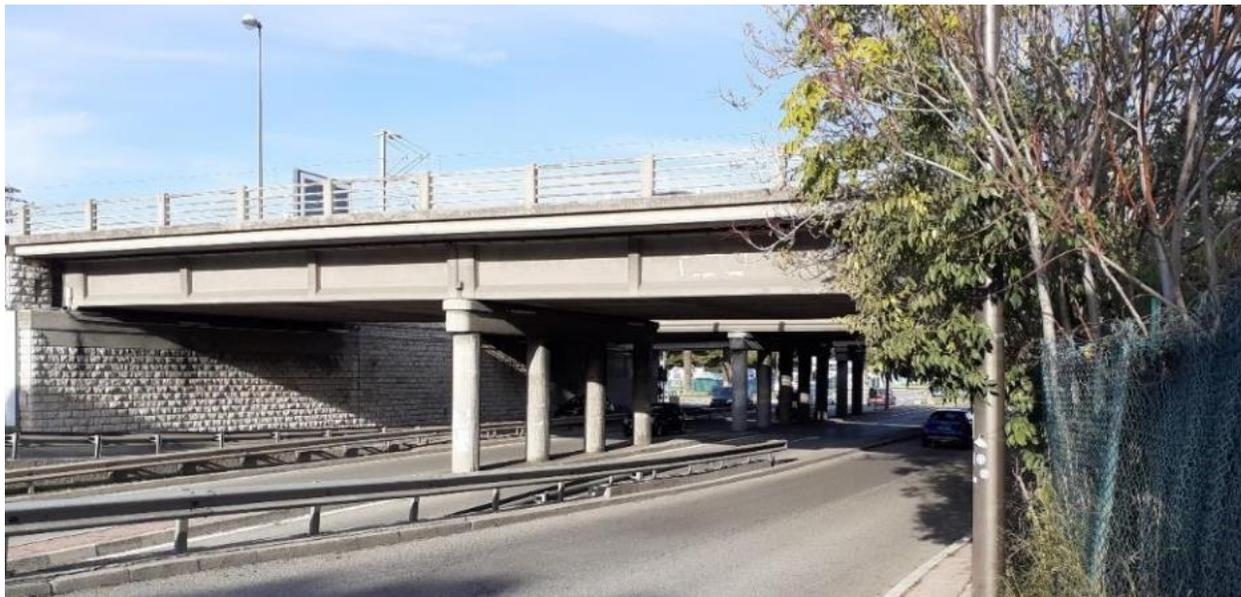
Remplacement de tabliers existants et reprise des piles centrales de l'ouvrage
